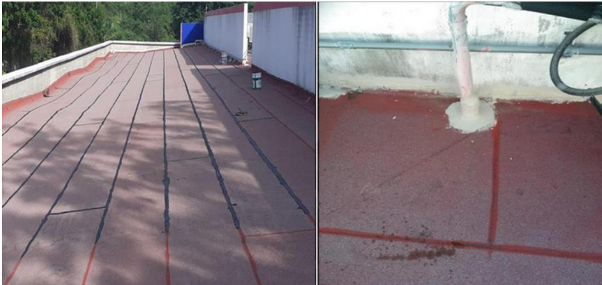
Edificio H Fuente: Departamento de Recursos Materiales y Servicios
