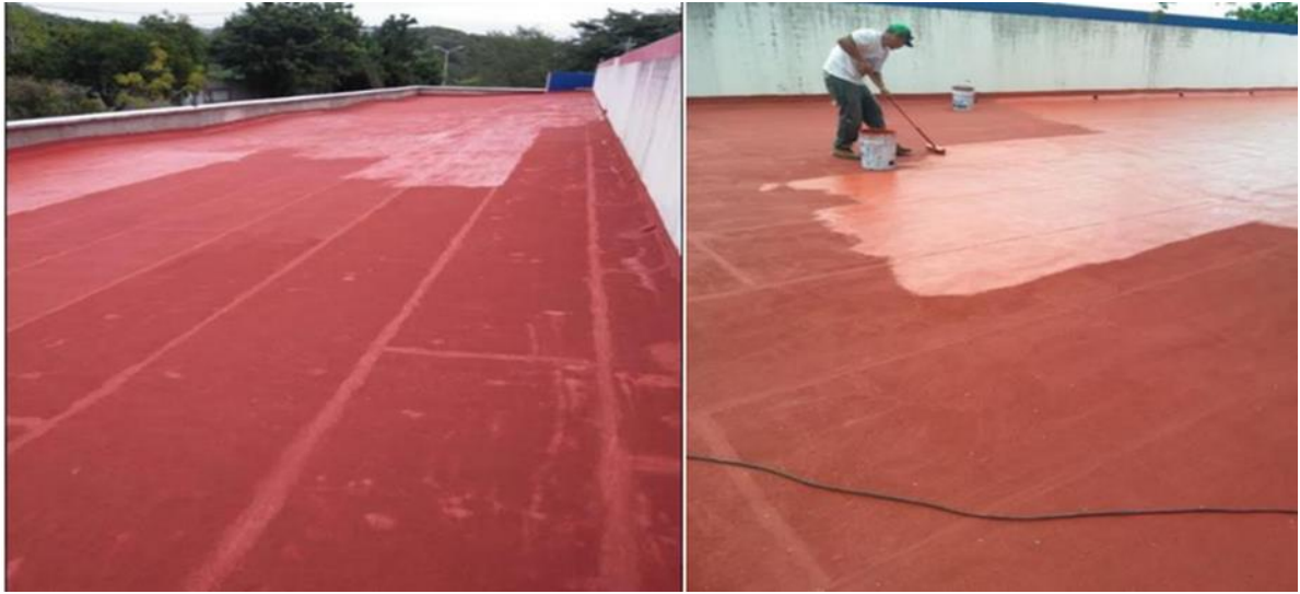
Edificio H Fuente: Departamento de Recursos Materiales y Servicios
