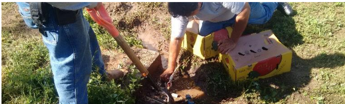
Ilustración 9 Reparación de fuga de agua. Fuente: Departamento de Recursos Materiales y Servicios.
