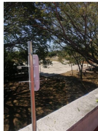
Ilustración 11. Instalación de antenas receptoras de wifi
