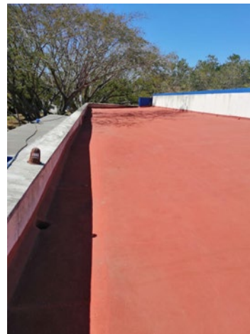
Ilustración 4. Verificación de impermeabilización edificio de Docencia
