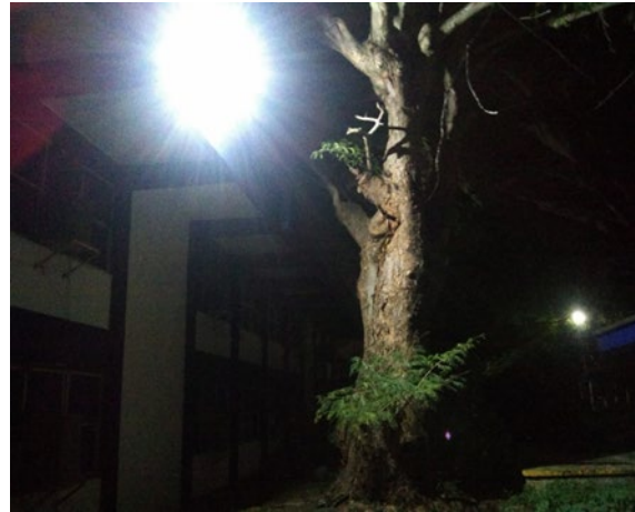
Ilustración 2. Instalación de Luminaria en áreas estratégicas dentro del plantel. (Costado de edificio H)
