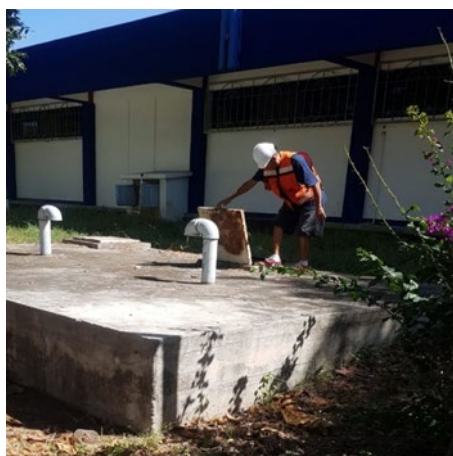
Ilustración 7. Mantenimiento de cisternas (Área de Laboratorios)
