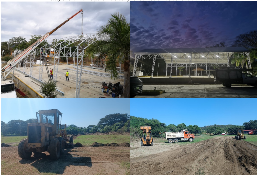
Fotografía 9. Domo para voleibol y rehabilitación de cancha de fútbol.
