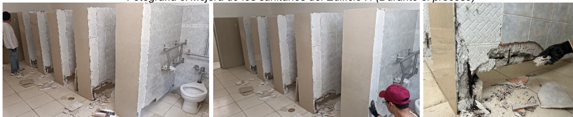
Fotografía 6. Mejora de los sanitarios del Edificio H (Durante el proceso)
