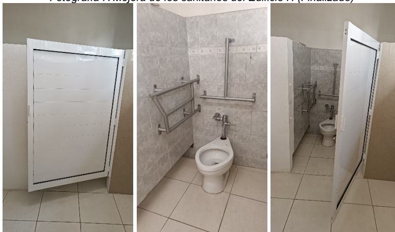
Fotografía 7. Mejora de los sanitarios del Edificio H (Finalizado)
