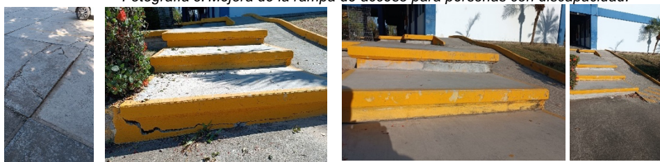
Fotografía 8. Mejora de la rampa de acceso para personas con discapacidad.
