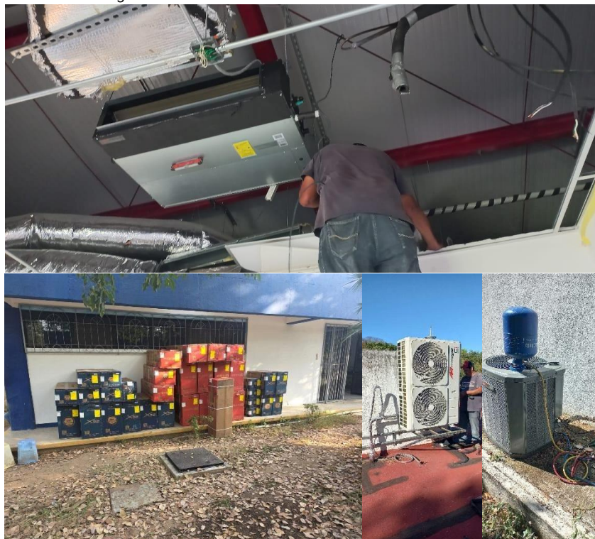
Fotografía3. Instalación de aires acondicionados en laboratorios.
